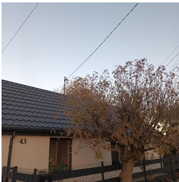
Fotografia 3 Istniejące przyłącze AsXSn zasilające posesję nr 43
