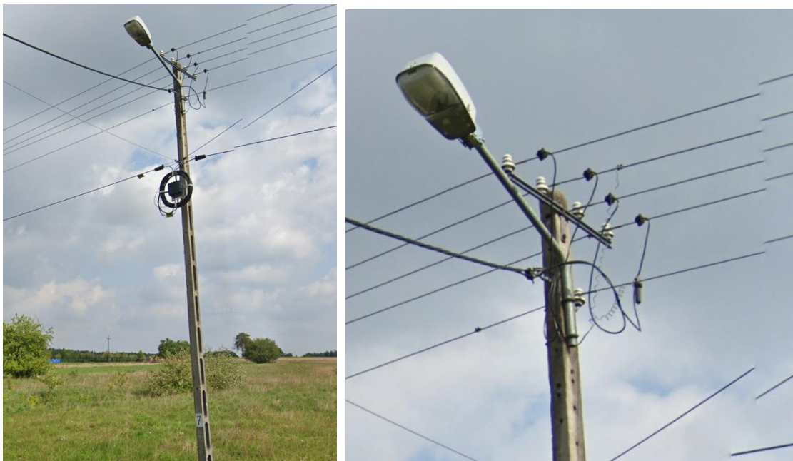
Fotografia 2istniejące przyłącze AsXSn zasilające posesję nr 15
